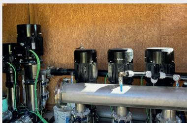
Pompes d'arrosage en bloc pour créer deux réseaux et console de gestion des pressions.
